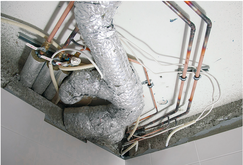
Kuva 10. Uudet putkistot voidaan asentaa vanhojen tilalle. Kuva: Fira Palvelut Oy.
