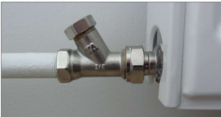
Kuva 45. Nykyaikaisen patterin sulkutulppa. Kuva: Kiinteistömedia Oy.
