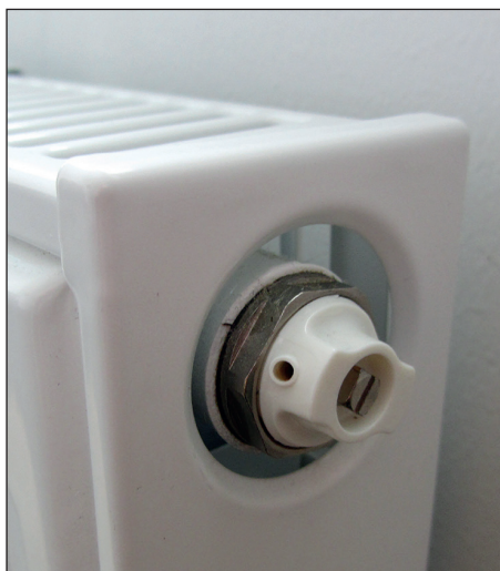
Kuva 47. Nykyaikainen lämmityspatterin ilmausruuvi. Kuva: Kiinteistömedia Oy.
