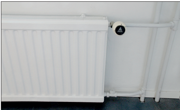
Kuva 36. Levyradiaattori 1970-luvun rakennuksessa. Kuva: Mika Petäjä.
