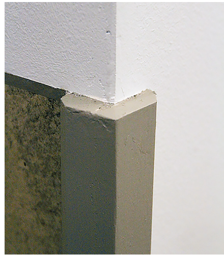
Kuva 4.1. Kulmalista seinän ulkonurkkaa suojaamassa. Kuva: Mika Petäjä.
