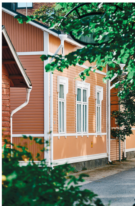
Kuva 4.8. Puinen maalattu julkisivu. Kuva: Bigstock.
