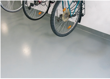
Kuva 4.5. Pintakäsitelty betonilattia taloyhtiön pyörävarastossa. Kuva: Kiinteistömedia Oy.
