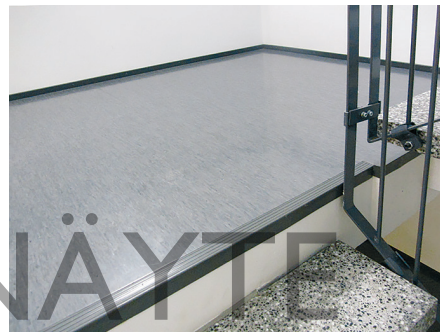
Kuva 4.4. Linoleumpäällysteinen lattia porraskäytävässä. Kuva: Kiinteistömedia Oy.
