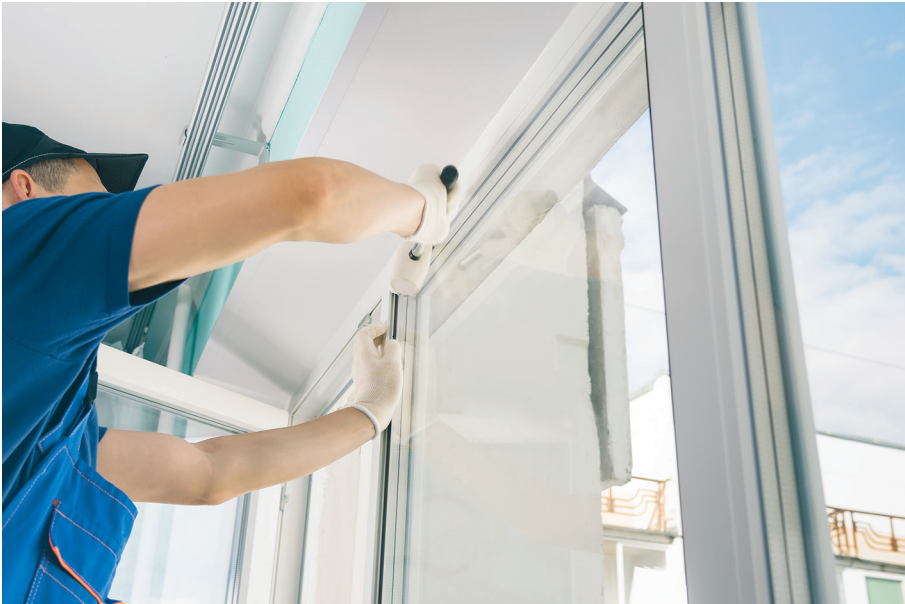
Kuva 4.10. Kiinteistön ikkunoita tulee huoltaa säännöllisesti. Kuva: Bigstock.
