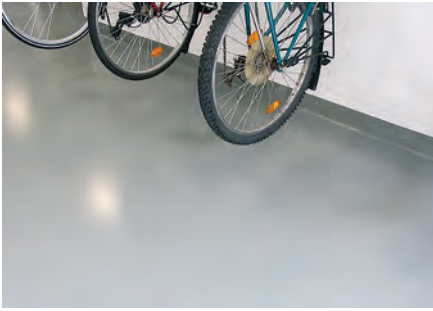
Kuva 4.5. Pintakäsiteltyä betonilattiaa taloyhtiön pyörävarastossa. Kuva: Kiinteistömedia Oy.
