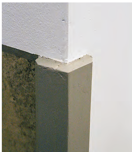
Kuva 4.1. Kulmalista seinän ulkonurkkaa suojaamassa. Kuva: Mika Petäjä.
