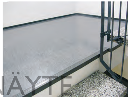
Kuva 4.4. Linoleumpäällysteinen lattia porraskäytävässä. Kuva: Kiinteistömedia Oy.
